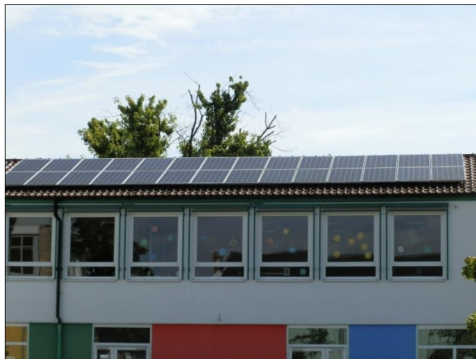
Schule – Aufstockung Seitengebäude/Fotovoltaikanlage
