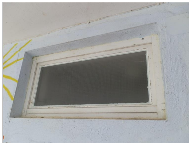
Altbau – Außen-WC/Einfachverglasung
