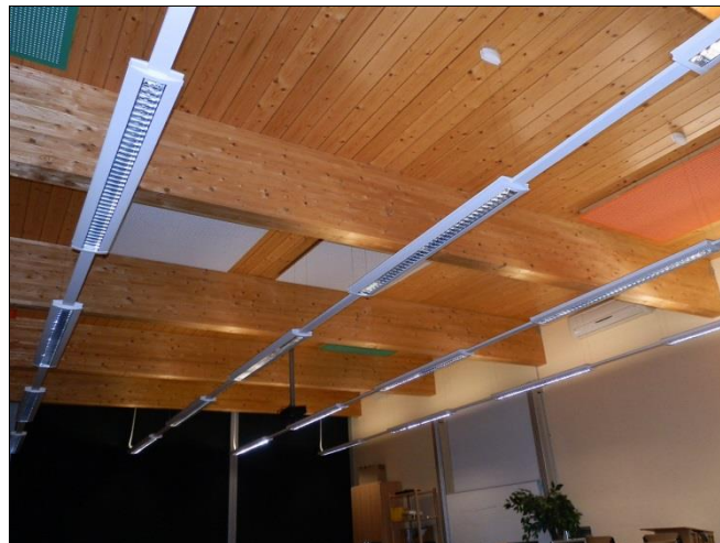
Mediathek/neue Leuchten mit T5-Lampen und EVG
