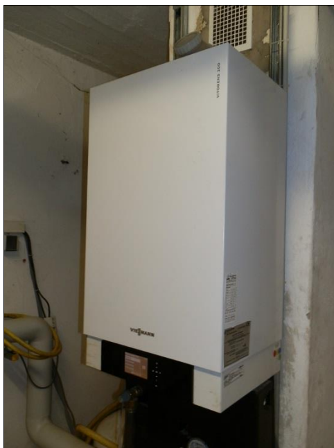
Brennwertgerät
