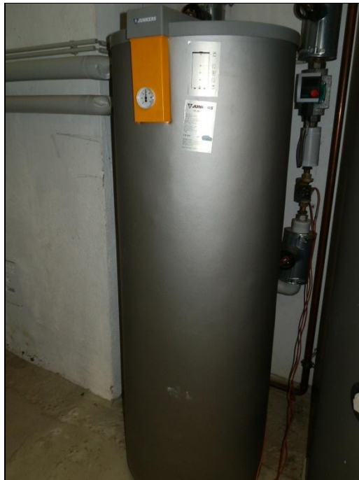
Zentrale Trinkwarmwasserbereitung
