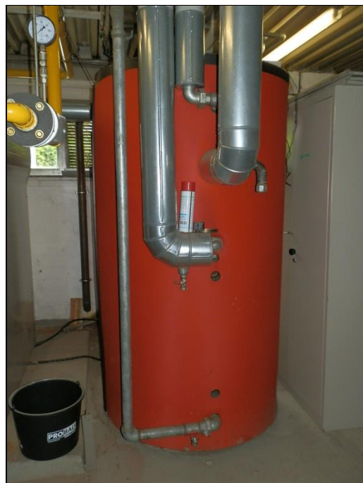
Zentraler Trinkwarmwasserbereiter
