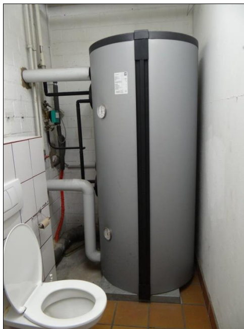
Zentraler Warmwasserbereiter
