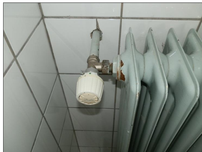
Küche/älteres Thermostatventil ohne Voreinstellung
