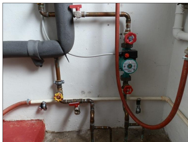
Umwälzpumpe Heizkörper
