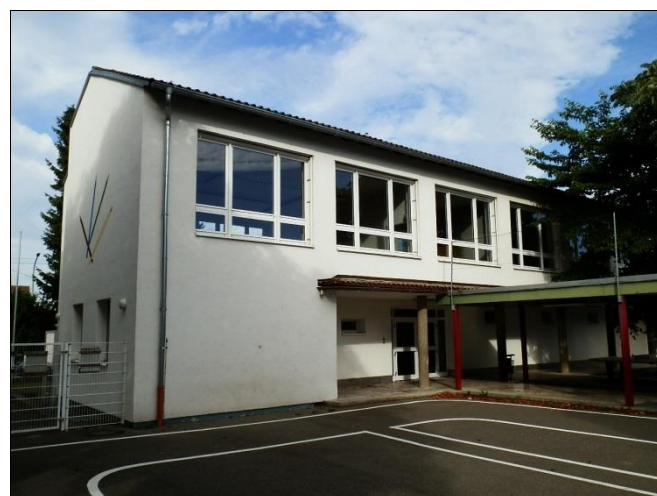
Altbau/Fassade mit WDVS, Ansicht Hofseite
