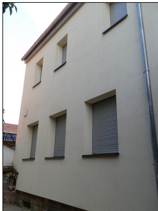
Altbau/Fassade mit WDVS, Ansicht Hofseite
