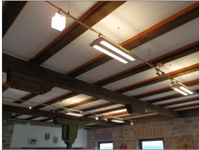
Neue Leuchten mit Halogen- bzw. TC-Lampen
