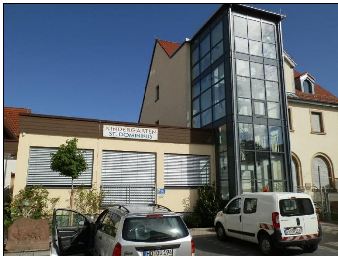
Fassade/Ansicht Straßenseite mit Erweiterung
