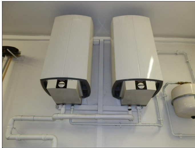
Elektrische Trinkwarmwasserspeicher
