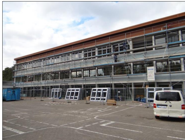
Schule – Altbau/Fassade, Ansicht Süd
