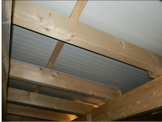
Pulldach Nebenräume mit Dämmung
