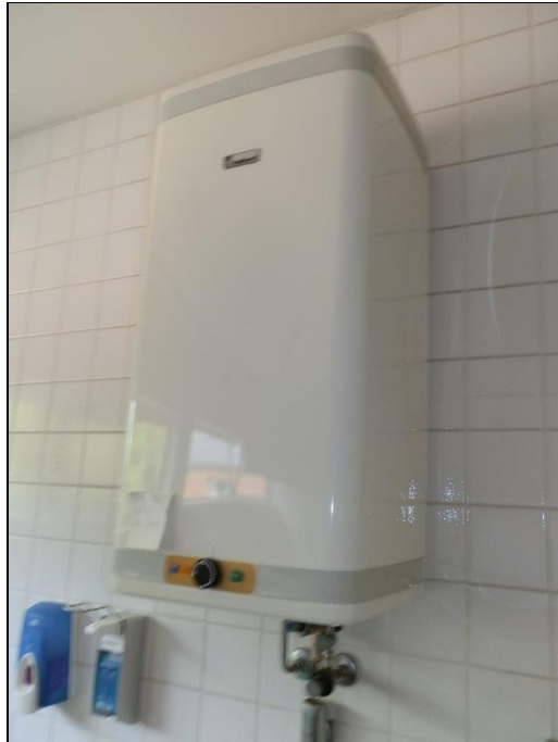
Küche/elektrischer Warmwasserspeicher
