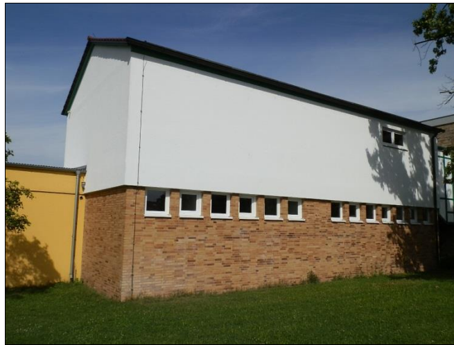
Seitenbau/Ansicht Ost- und Südseite
