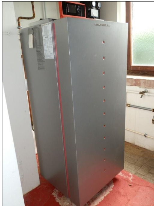
Brennwertgerät
