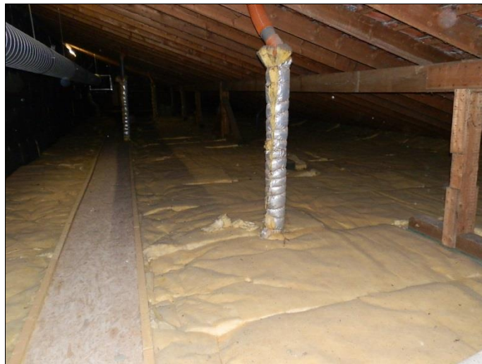
Dämmung oberste Geschosdecke
