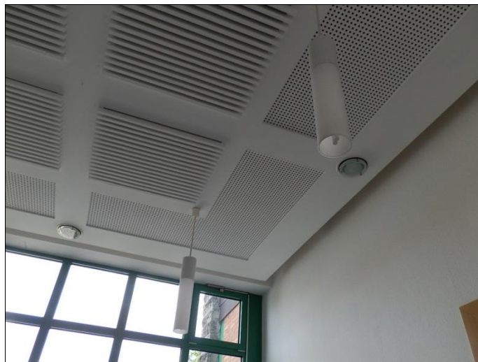
Foyer – Anbau 1999/Kompaktleuchtstofflampen
