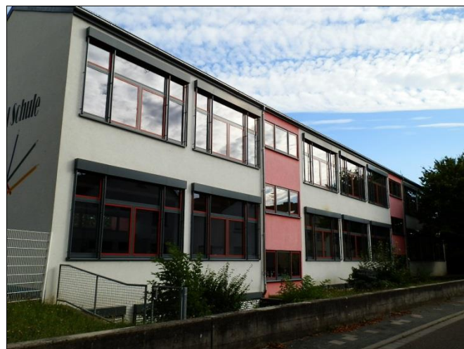
Neubau/Fassade mit WDVS, Ansicht Straßenseite
