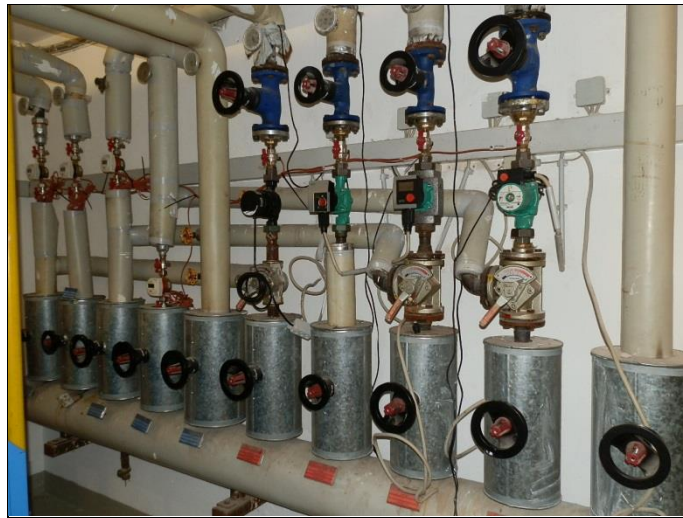
Verteiler/Umwälzpumpen
