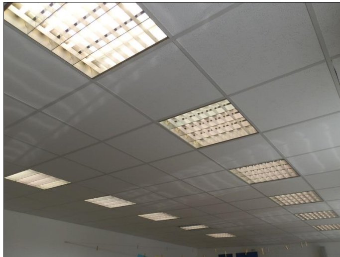
Schule – Altbau/Klassenraum, Rasterleuchten
