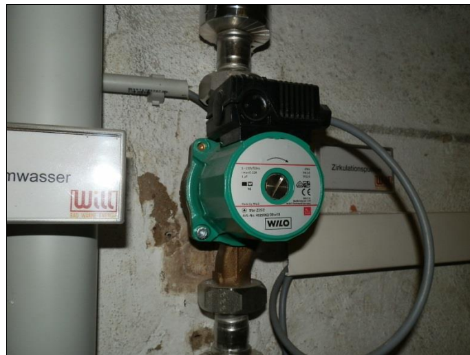
Zirkulationspumpe Altbau
