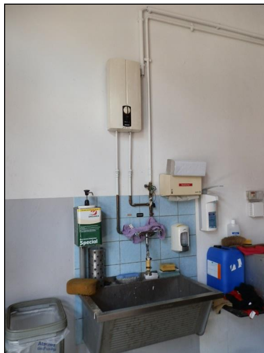
Elektrischer Durchlauferhitzer
