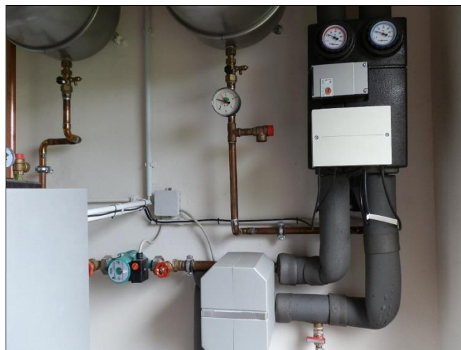
Umwälzpumpen Fußbodenheizung
