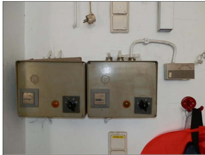
Schaltung bzw. thermostatische Steuerung der Gebläseheizung
