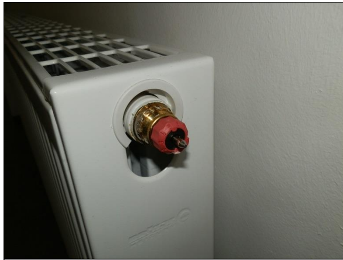
Schulungsraum/Ventilheizkörper mit voreinstellbarem Ventil
