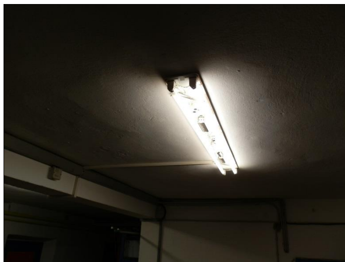
Schule – Altbau/UG, alte Leuchten ohne Abdeckung
