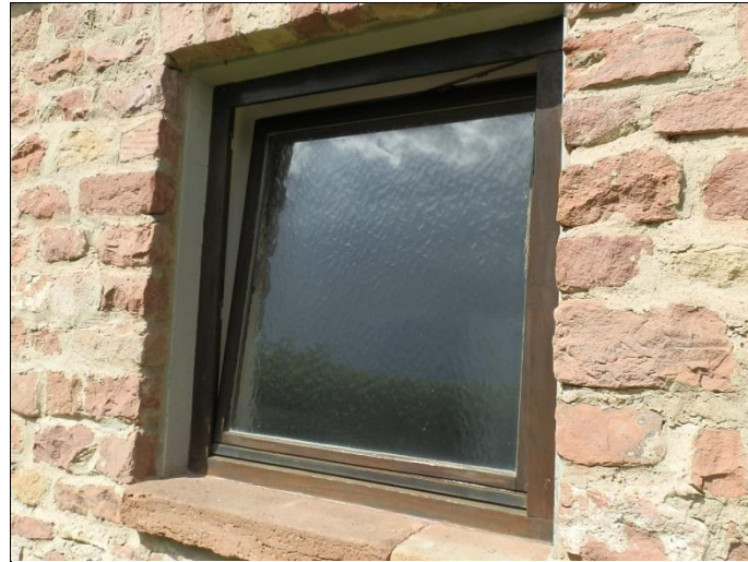
Alte Isolierverglasung, 1975
