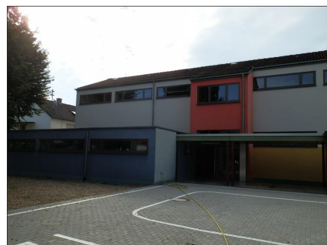
Neubau/Fassade mit WDVS, Ansicht Hofseite
