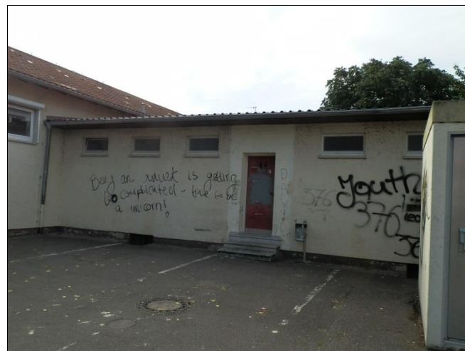
Altbau – Außen-WC/Fassade, Ansicht Rückseite
