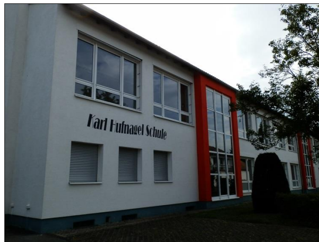
Altbau/Fassade mit WDVS, Ansicht Straßenseite
