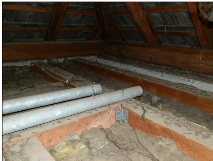
Dämmung oberste Geschosdecke
