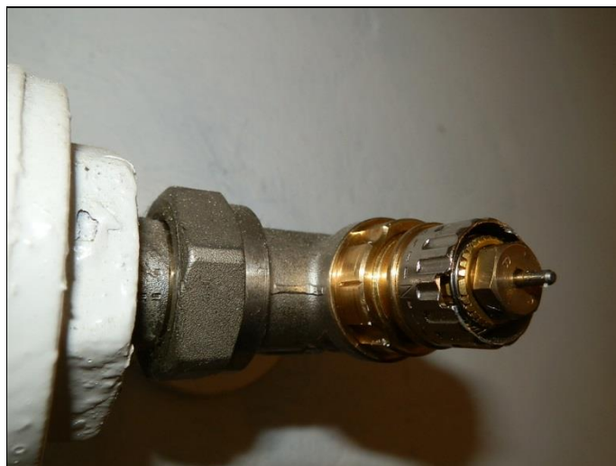
Voreinstellbares Thermostatventil
