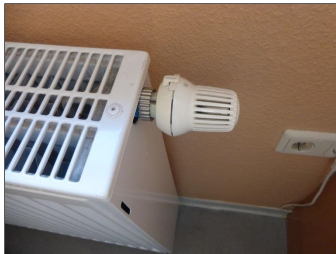
Heizkörper mit voreinstellbarem Thermostatventil
