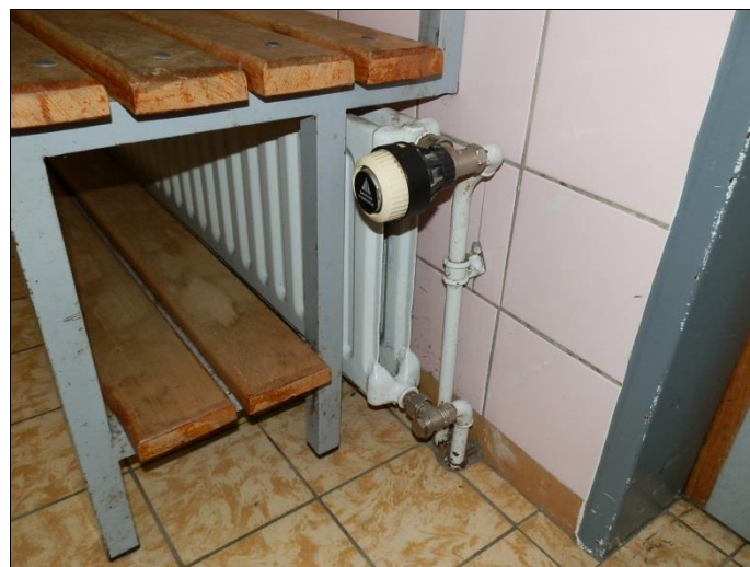
Mehrzweckhalle/Thermostatventil
