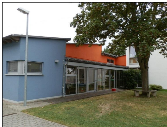
Messagebaude/Fassade, Ansicht West
