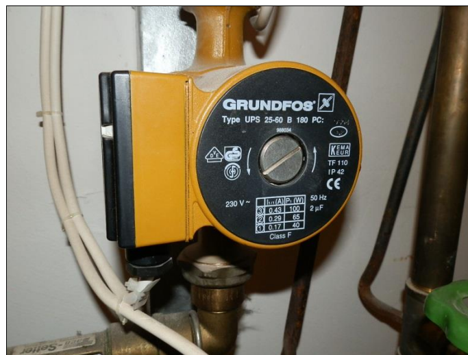
Zirkulationspumpe Neubau
