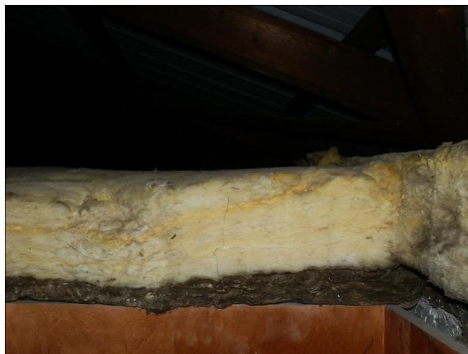
Dämmung oberste Geschossdecke
