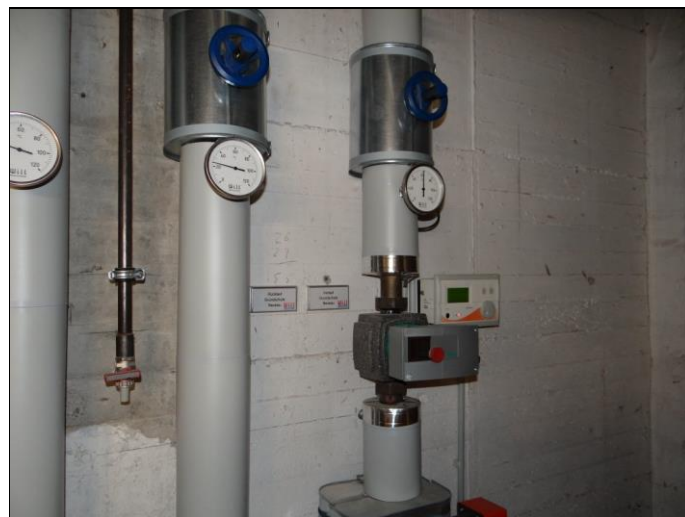
Unterverteilung Neubau/Hocheffizienzpumpen
