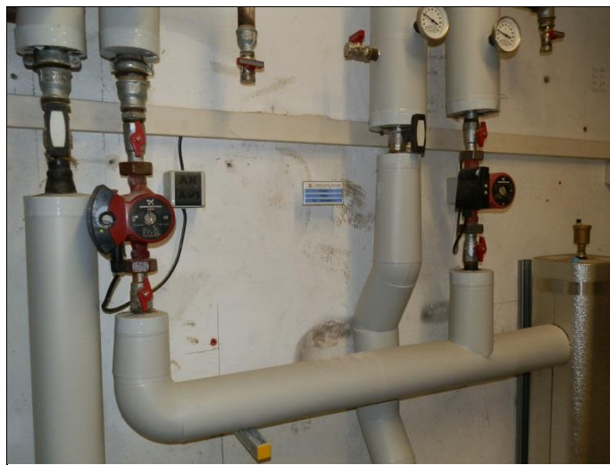
Heizungsumwälzpumpen Altbau
