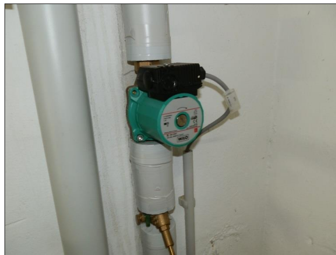
Zirkulationspumpe
