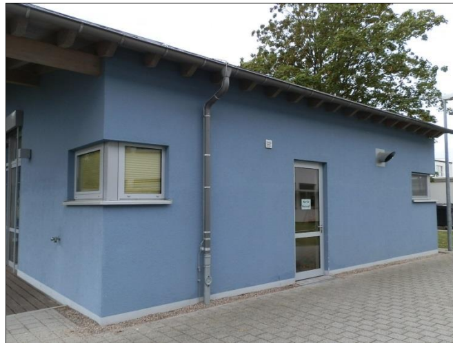
Messagebaude/Fassade, Ansicht Nord
