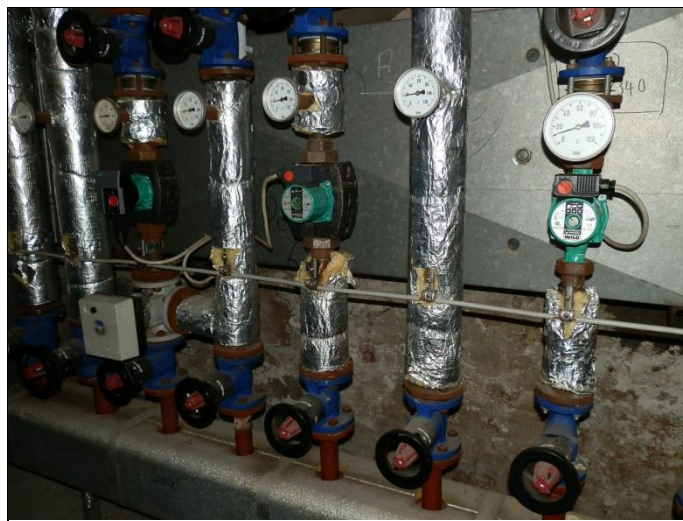
Umwälzpumpen/Verteiler
