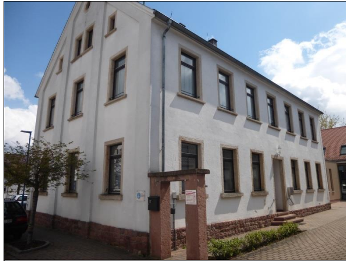
Fassade/Ansicht Nord und West
