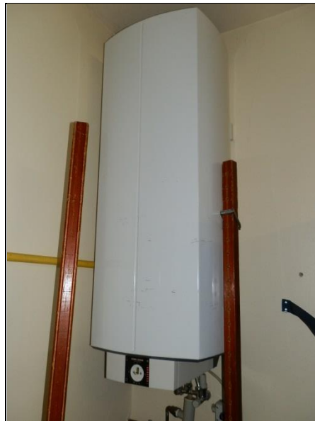
Mehrzweckhalle/elektrischer Trinkwasserwärmere
