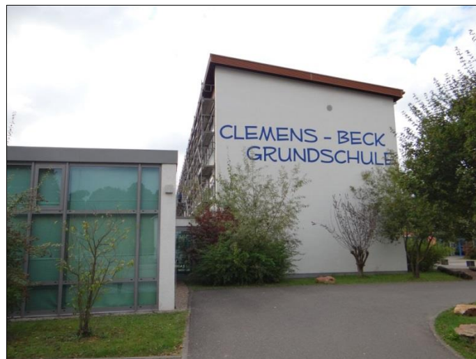
Schule – Altbau/Fassade, Ansicht Ost
