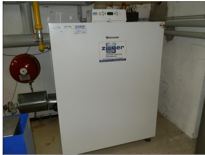
Brennwertgerät
