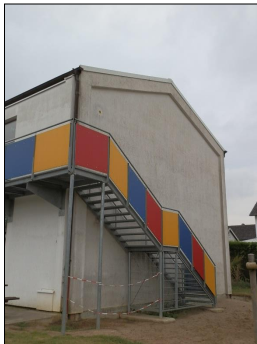
Altbau/Fassade, Ansicht West
