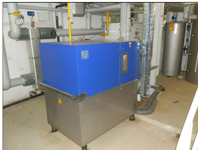
Blockheizkraftwerk
