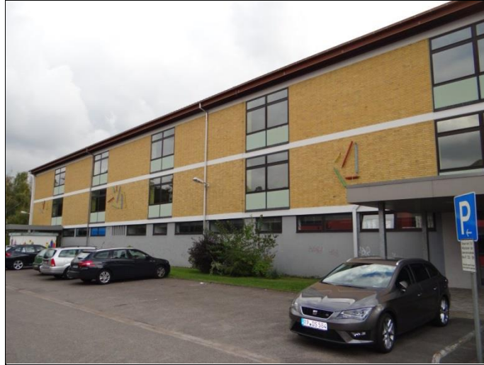
Schule – Altbau/Fassade, Ansicht Nord
