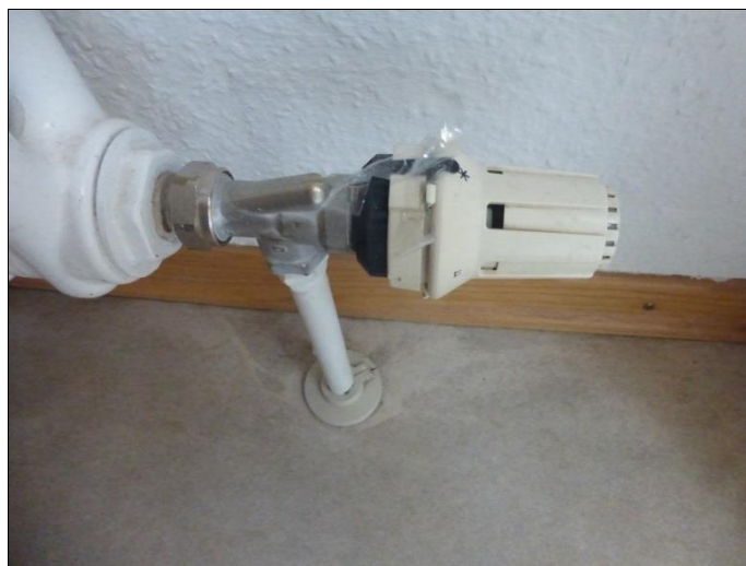
Neubau/Thermostatventil mit Voreinstellung
