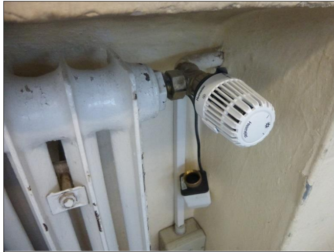
Thermostatventil ohne Voreinstellung
