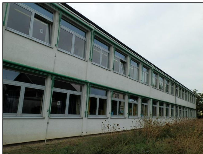
Altbau/Fassade, Ansicht Süd
