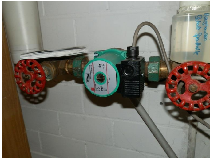
Zirkulationspumpe
