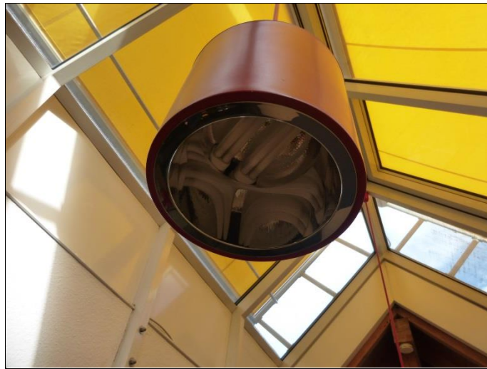
Neubau/Hängeleuchte mit Kompaktleuchtstofflampe
