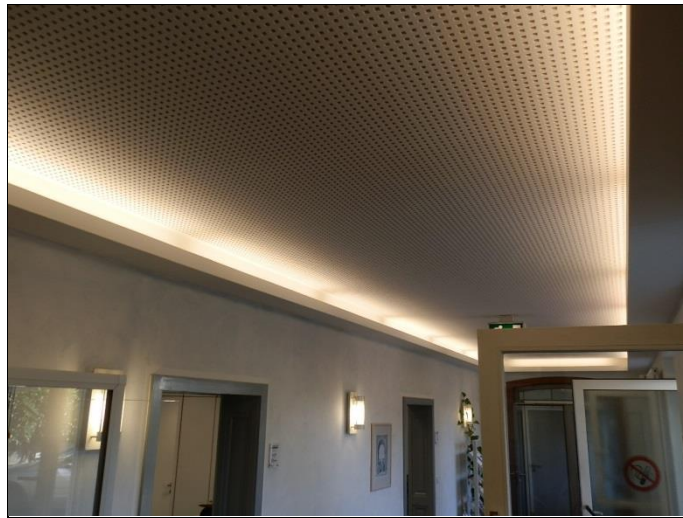
Flur – EG/indirekte Beleuchtung
