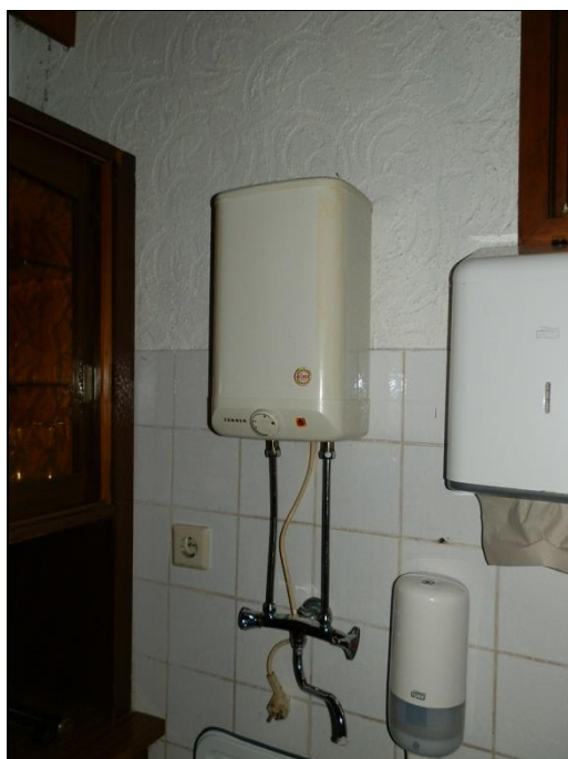
Elektroboiler Barraum
