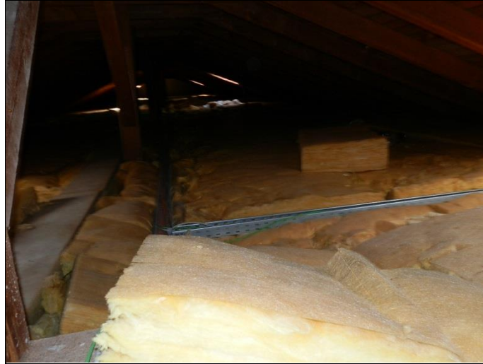
Dämmung oberste Geschossdecke
