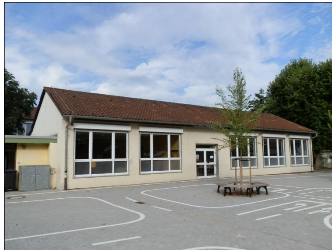
Altbau – Pavillontrakt/Fassade, Ansicht Hofseite
