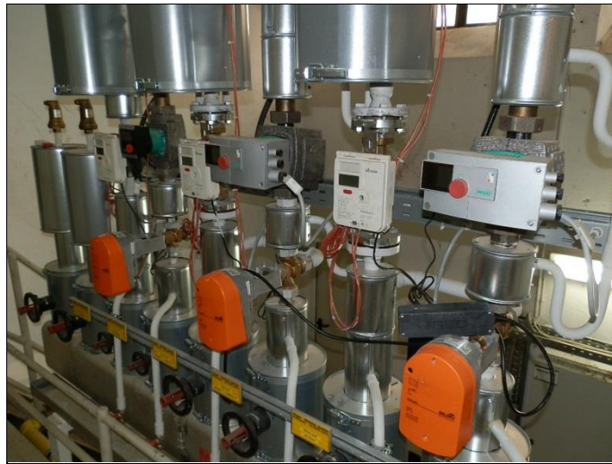
Heizungsverteiler/Hocheffizienzpumpen
