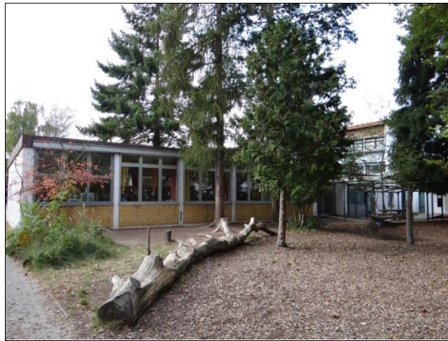
Mensa/Fassade, Ansicht Ost
