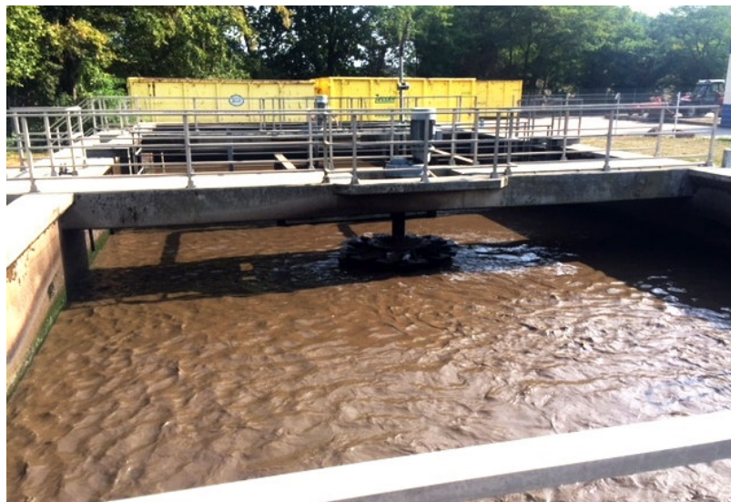
Bild 20: Belebungsbecken der KA Römerberg
